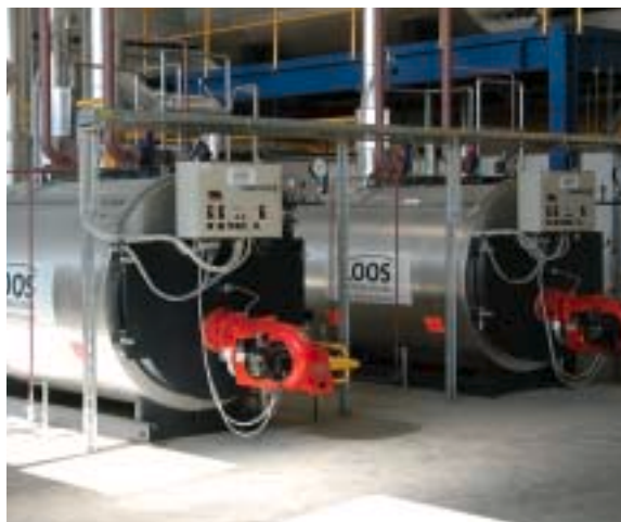
Dos generadores de vapor de alta presión UNIVERSAL: calderas U-HD para la producción de vapor saturado
