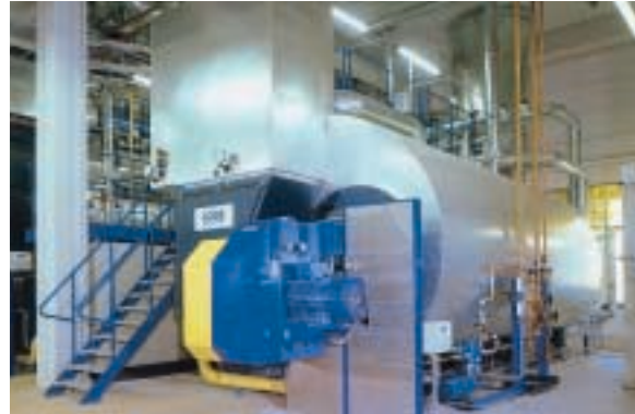
Generador de vapor de alta presión UNIVERSAL UL-SX con módulo de recalentamiento para producción de vapor sobrecalentado
