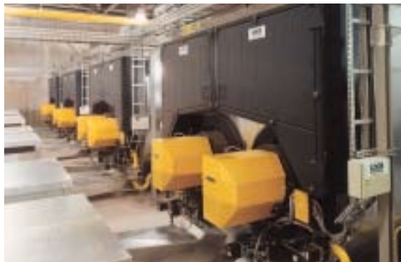
Cuatro calderas de dos hogares ZFR para producción de vapor saturado, aptas para funcionamiento paralelo o de un hogar
