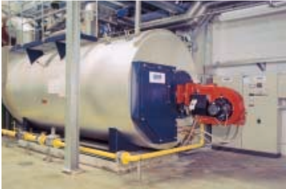
Generador de vapor de alta presión UNIVERSAL UL-S para producción de vapor saturado
