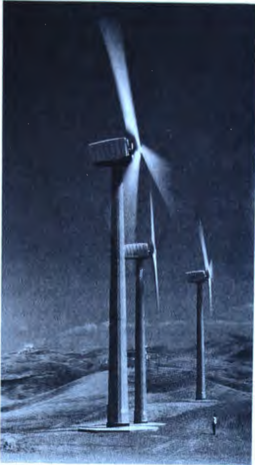
Figura 5.3 Turbinas eólicas dispuestas en línea en una “granja eólica”. Estas turbinas, que generan 400\text{ kW} cada una de ellas, tienen un diámetro de 33\text{ m} y sus ejes se encuentran 30\text{ m} por encima del nivel del suelo. (Fotografía cortesía de U.S. Windpower.)
