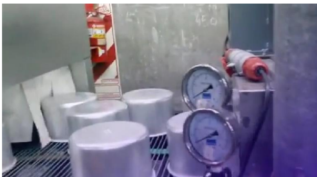
Figura n° 24. Entrada a cámara
